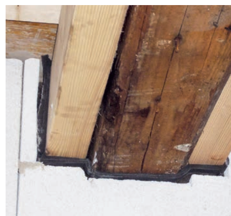
Die sauber abgedeckte Fenster-Anschlussfuge und die Dämmung mit mineralischen Multipor-Platten.
