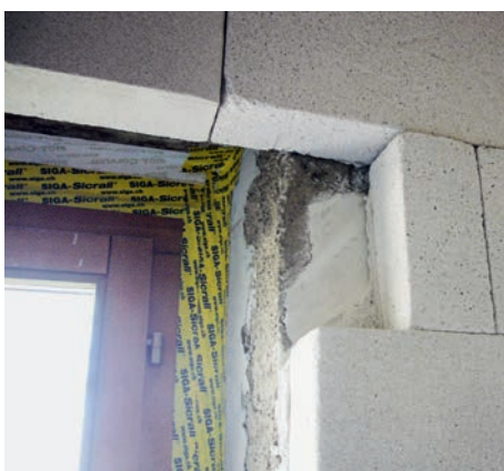
Die sauber abgedeckte Fenster-Anschlussfuge und die Dämmung mit mineralischen Multipor-Platten.
