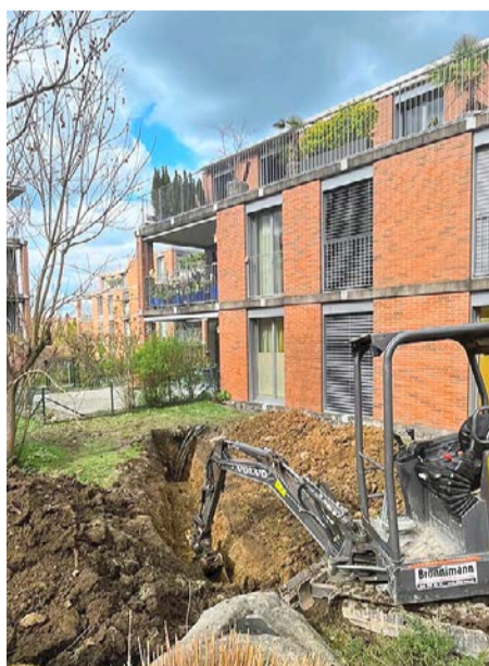
Rechts: Nach den Bohrungen werden 80 cm tiefe Gräben gebaggert, um die Leitungen der drei Erdsonden zusammenzuführen. BILD HEV SCHWEIZ
